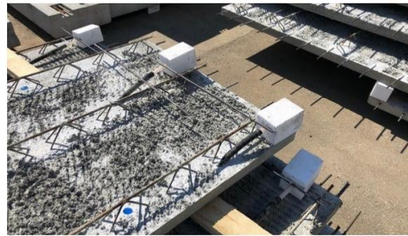
4. Je nach gewählter und geplanter Ausführung kann die Verbindung der Rohrschlangen und die Anbindung an die Versorgungsleitungen innerhalb der Decke oder auf der fertigen Decke erfolgen.
