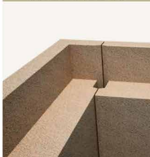
Deckenaufkantung – klimaPOR-Wand
