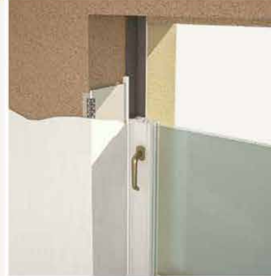
Fensteranschlag (Ausbaudetail hauseits)
