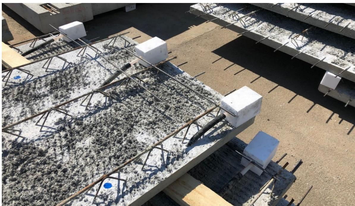
Die Aussparungskörper sind so anzuordnen, dass sie nicht unter aufgehenden Wänden positioniert sind. Die Entfernung der Aussparungskörper sollte erst kurz vor dem Anschluss der Rohrleitungen erfolgen.
