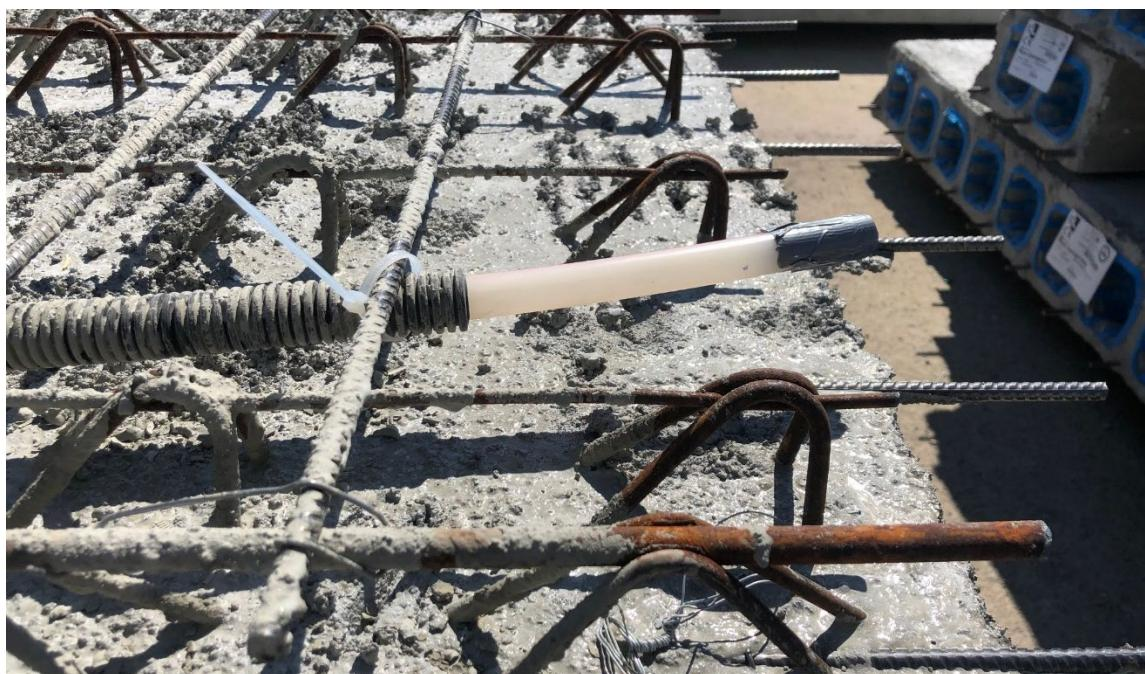
Je nach gewünschter Ausführung kann die Verbindung der Rohrschlangen und die Anbindung an die Versorgungsleitung auf der Decke oder innerhalb der Decke erfolgen. Bei Ausführung als letzte Geschossdecke unterhalb des Dachstuhls erfolgt die Verbindung der Rohrschlägen in jedem Fall in der Decke. Hierbei muss zwingend der zuständige Heizungsbauer mit auf der Baustelle sein.
